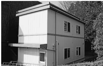
写真1 仮設修復施設の外観
